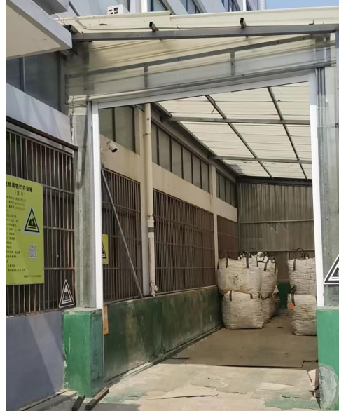
企业现有污泥间实景照片
